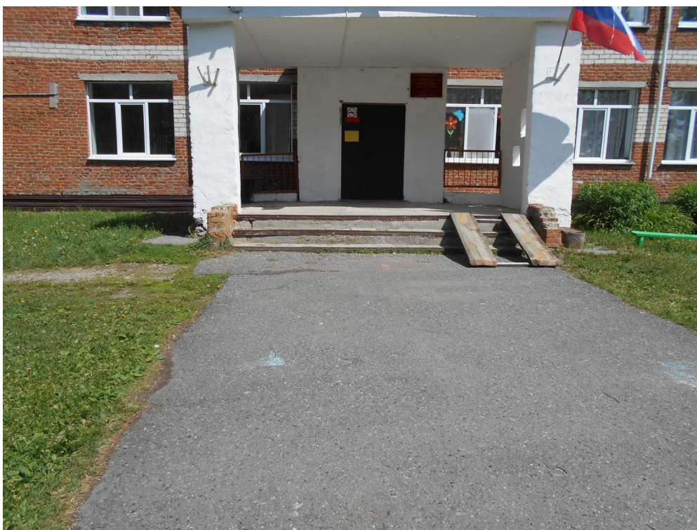
Фото №1-2 (Входная площадка)
