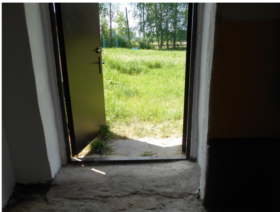
Фото №2-1 (Пути эвакуации)
