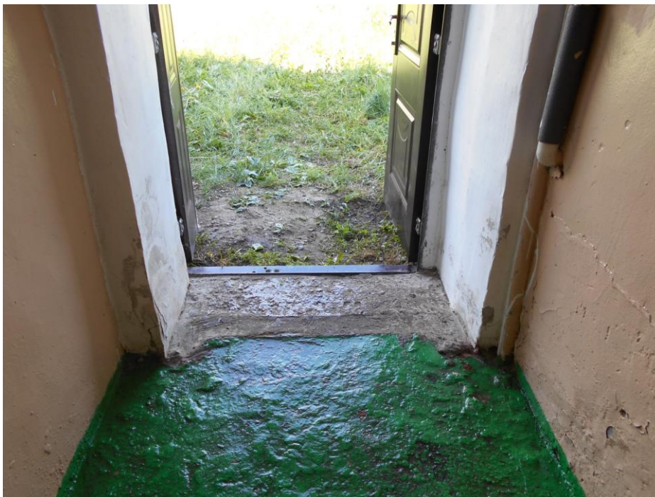
Фото №2-2 (Пути эвакуации)
